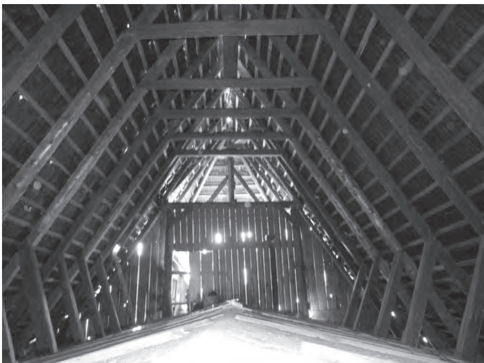
Obr. 3a, b. Múzeum oravskej dediny Zuberec-Brestová (Orava), drevený r. k. Kostol sv. Alžbety Uhorskej. Krov nad loďou a priečna väzba (1644 – 1645 d). Foto autori článku, 2009 Pic. 3a, b. Museum of the Orava village Zuberec-Brestová (Orava), wooden Roman Catholic Church of St Elizabeth of Hungary – roof frame above the nave, cross rafters (1644 – 1645 d). Photo by the authors of the article, 2009
