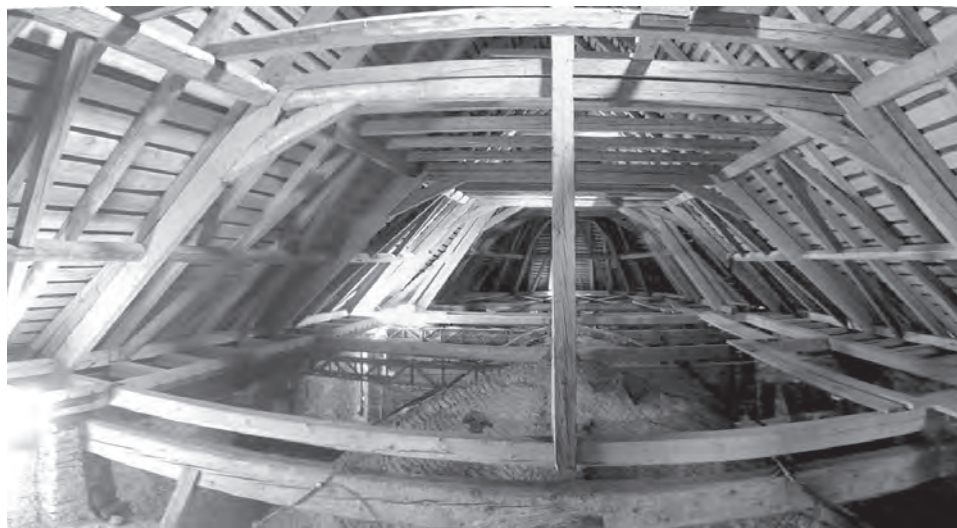
Obr. 12. Zákopčie (Kysuce), r. k. Kostol sv. Jána Krstiteľa – plná priečna väzba (1790 – 1791 d). Foto autori článku, 2009
