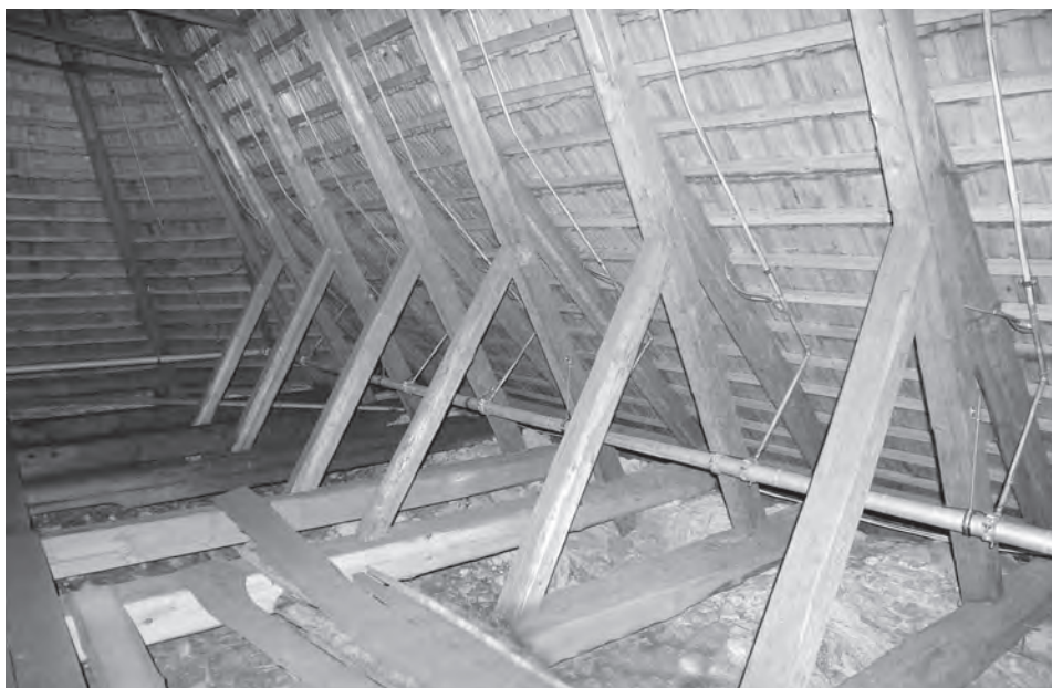
Obr. 4b, c. Orawka (PL), drevený r. k. Kostol sv. Martina – krov. Rez priečnej väzby krovu (1651 – 1656).
