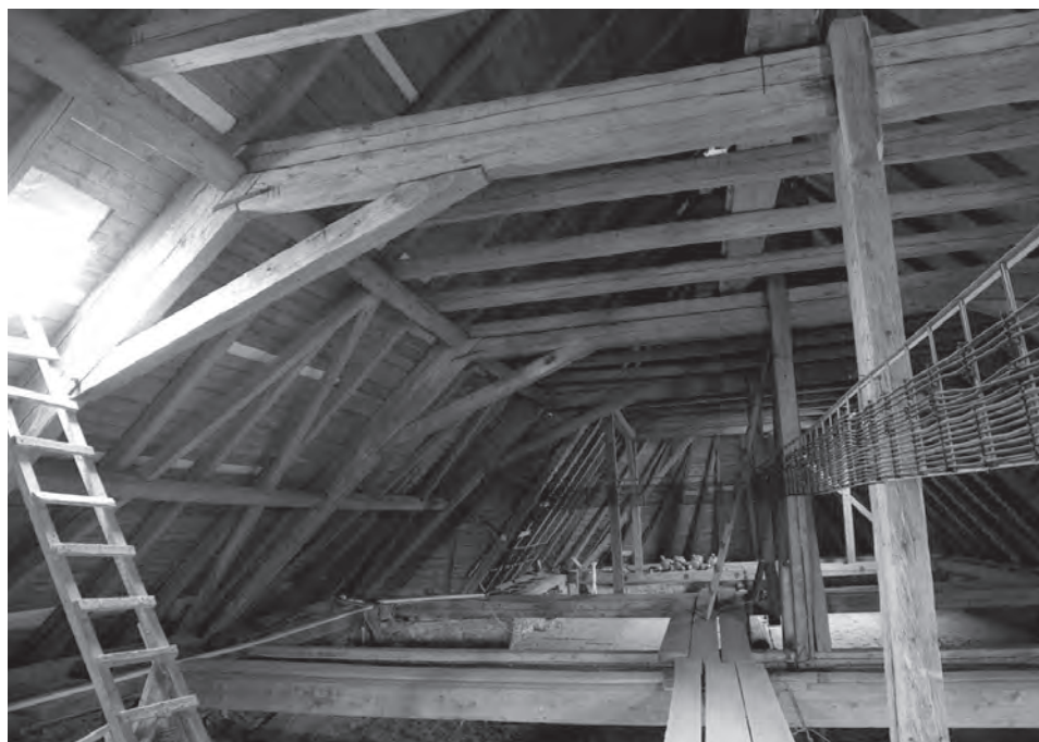
Obr. 8. Oravské Veselé (Orava), r. k. Kostol sv. Alžbety – hambáľkový krov s ležadymie stolicami (1803 – 1804 d). Foto autori článku, 2009
