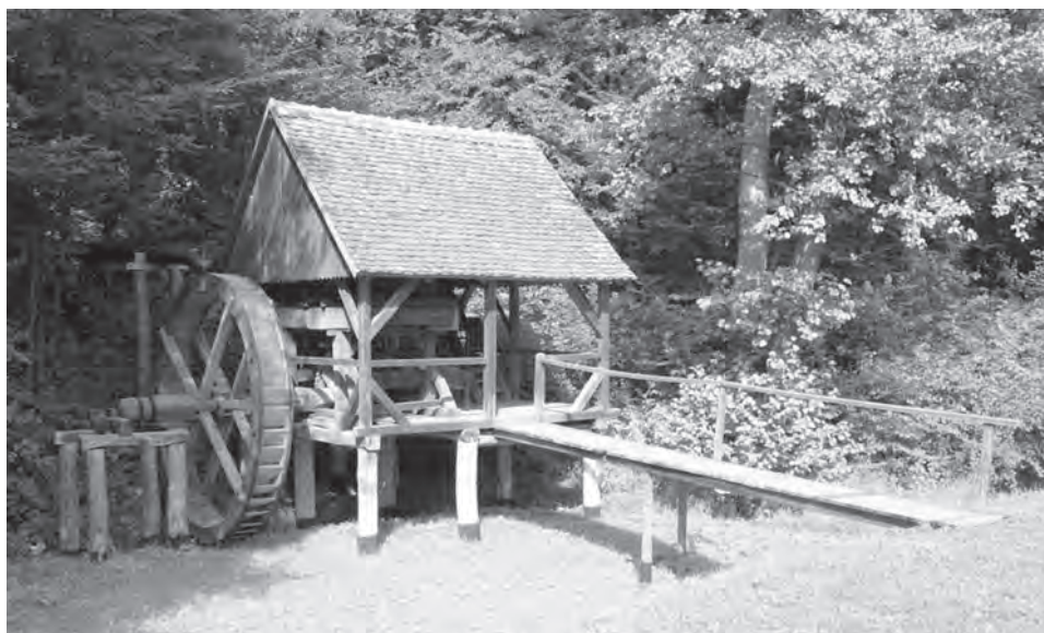
Pic. 2. Water mill with overshot wheel and drive in two steps from Rogojelu (Cluj County) in the ASTRA Museum of the Traditional Folk Civilization. Archives of the ASTRA National Museum Complex Obr. 2. Vodný mlyn na vrchnú vodu s dvojstupňovým prevodom z Rogojelu (Klužská oblasť) v ASTRA Múzeu tradičnej ľudovej kultúry. Archív ASTRA Národného múzejného komplexu
