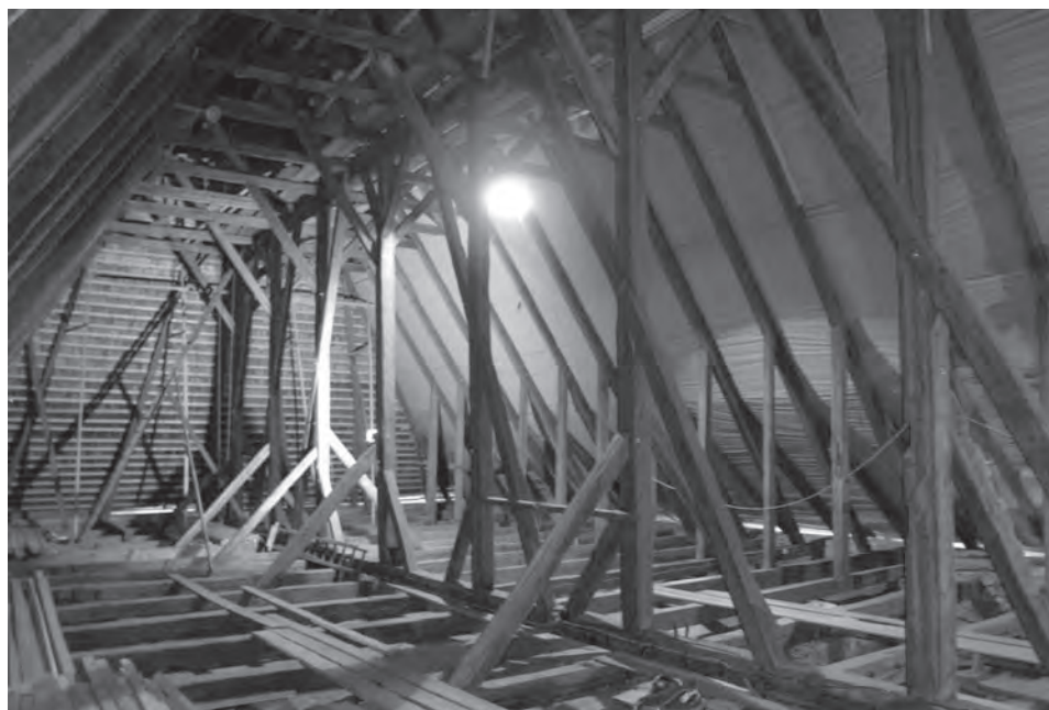
Obr. 6a, b. Veličná (Orava), r. k. Kostol sv. Michala – pohľad do krovu. Rezy plnou a medziľahlou priečnou väzbou (1736 – 1737 d). Foto autori článku, 2009
